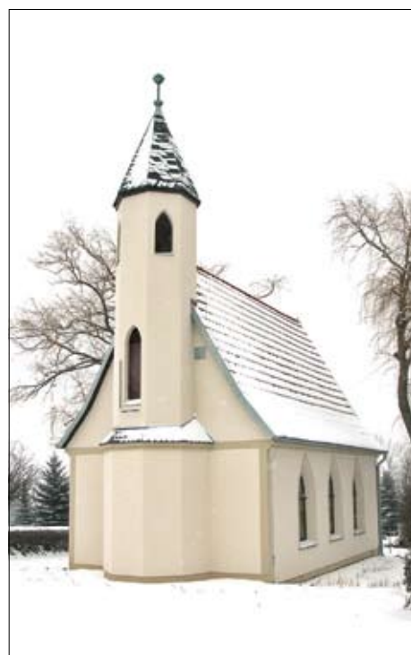
Die sanierte Friedhofskapelle leuchtet wieder als Wahrzeichen über Timmenrode.
