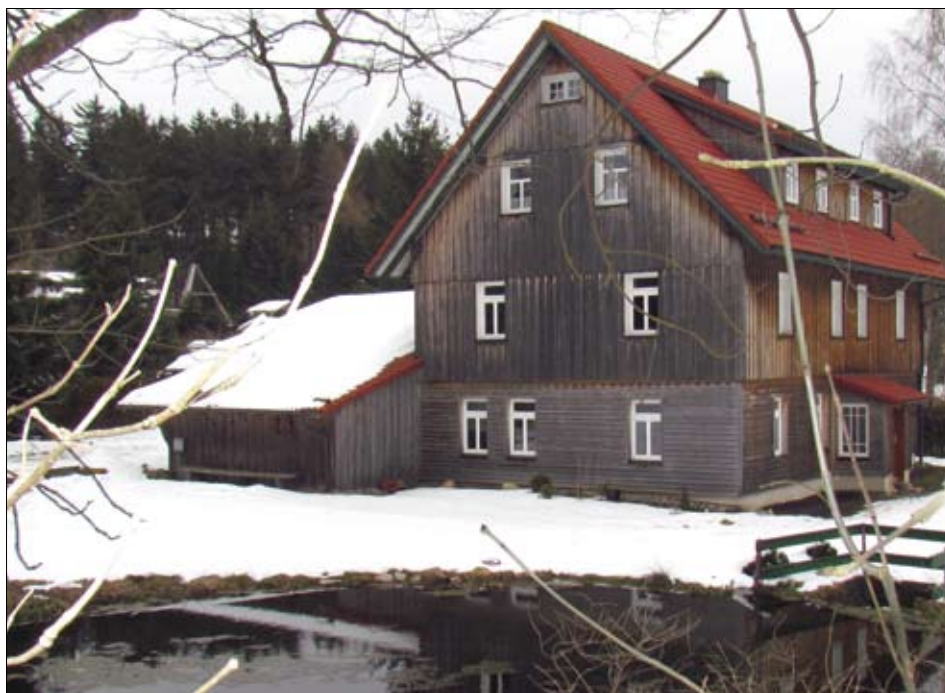
Die Gebäude der heutigen Siedlung Eggeröder Brunnen werden zu Ferien- und Erholungszwecken genutzt.
