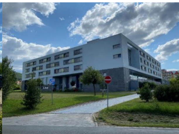
Abbildung 19: Seniorenwohnanlage Waldfriedenstraße 1b
