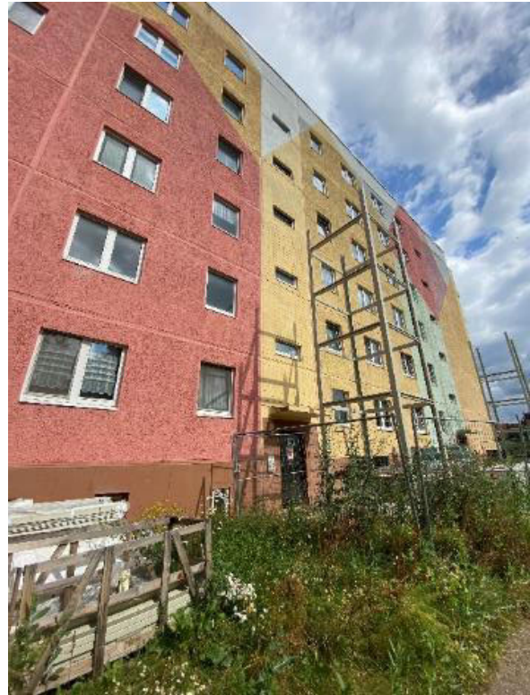
Abbildung 31: Bau von Aufzügen Adolf-Ledebur-Ring 21-24
