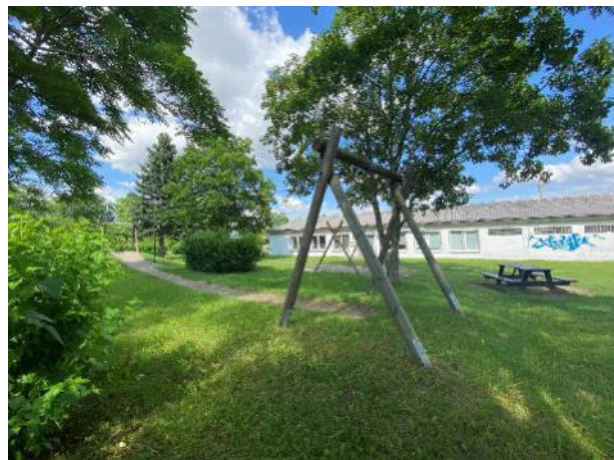
Abbildung 29: Unsaniertes Zustand Vereinsheim Zur Alten Schule
