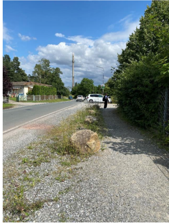
Abbildung 38: schlecht ausgebauter, unbefestigter Fußweg Am Lindenberg
