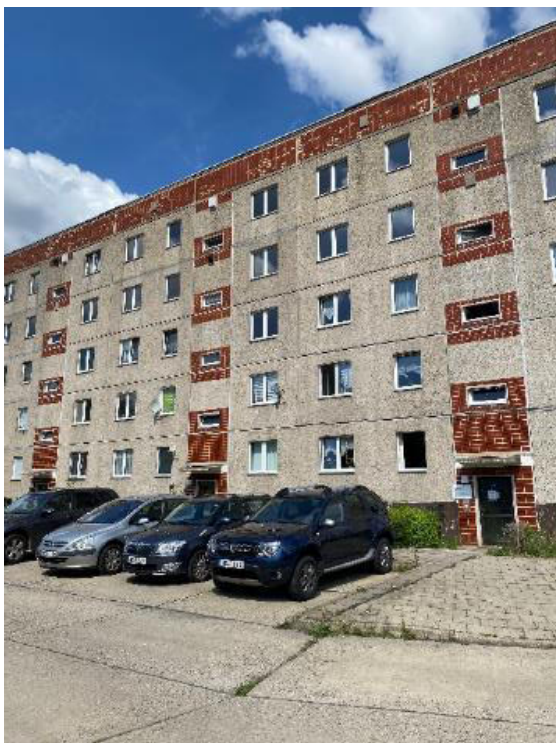
Abbildung 28: Unsaniertes Zustand Adolf-Ledebur-Ring 3-5
