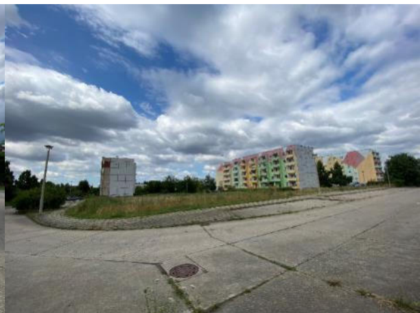
Abbildung 17: Abbruchfläche ehemals Adolf-Ledebur-Ring 6-13
