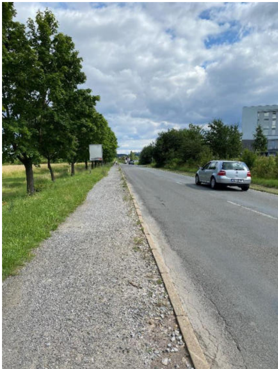
Abbildung 39: Fußweg mit Erneuerungsbedarf der Oberfläche entlang der Michaelsteiner Straße
