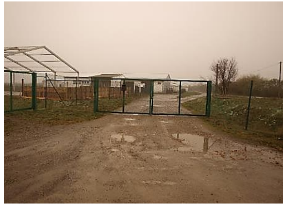
Schweinemastanlage im Nordosten der Teilfläche (Blick vom Eingangsbereich nach Süden)
