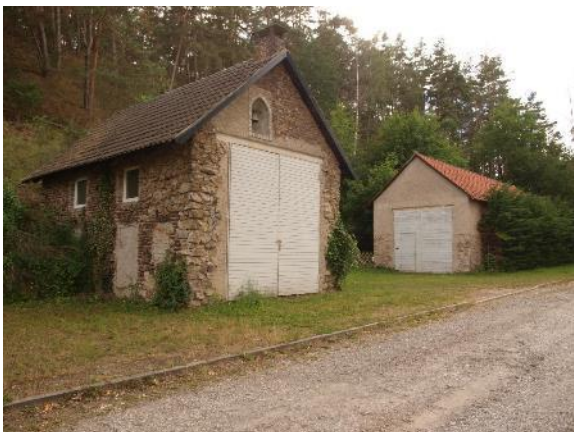
Straßenansicht: südliche Nebengebäude und Sandsteinhang (Blick nach Südwesten)
