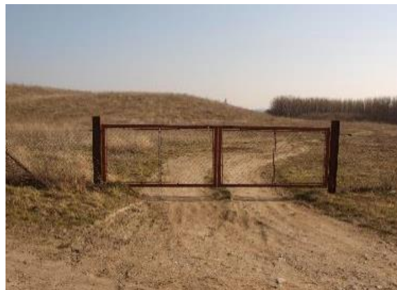
Eingangsbereich und offener Teilbereich der abgedeckten Deponie auf 2,0 ha (Blick nach Süden)
