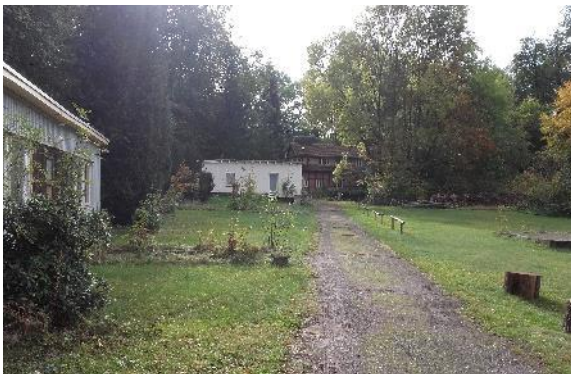
Nebengebäude, Fachwerkscheune und Freiflächen (Blick nach Nordosten)
