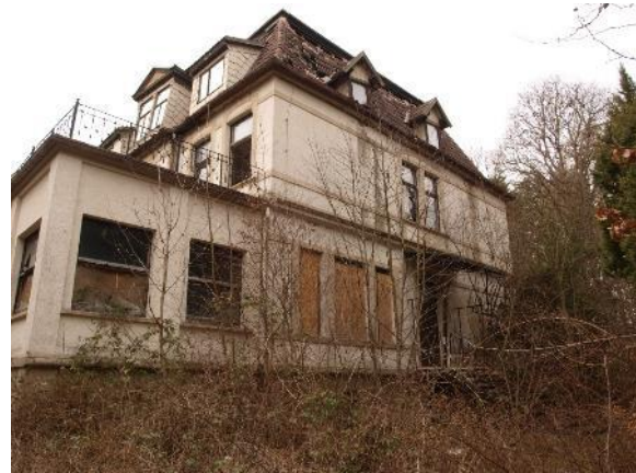
Zunehmend verfallendes Haupthaus (Blick auf die Ostfassade)
