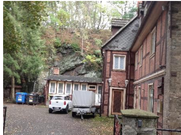
Bestehendes Hauptgebäude mit ehemaliger Gaststätte und angrenzendem Hangbereich (Blick nach Südosten)
