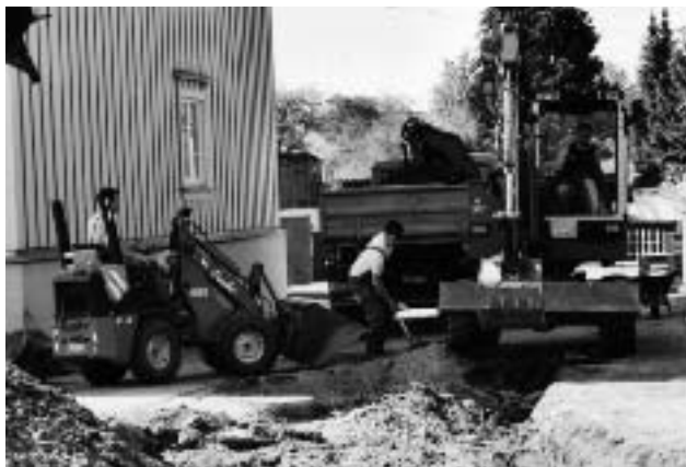
Entlang der Kita und der Schule wurde in Eigenleistung der gepflasterte Weg bis zur Cattenstedter Kirche angelegt.
