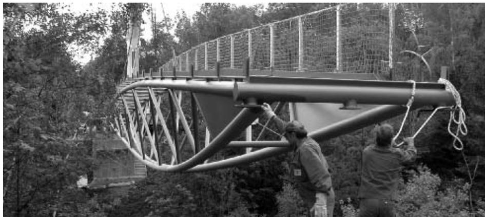
Nach 20 Minuten hatte der Kran die Brückenkonstruktion in ihre Verankerungen auf den Brückenpfeilern gehoben.
