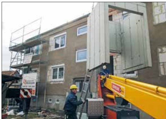
Hier entstehen die altersgerechten Wohnungen.
