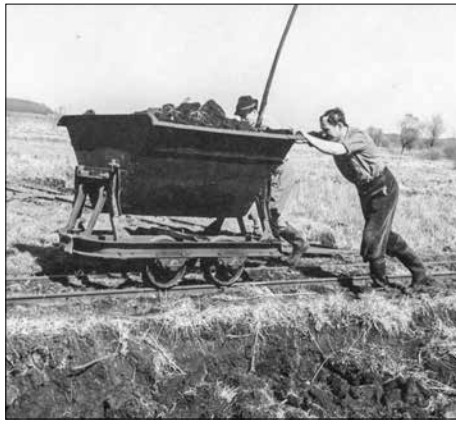
Abtransport des Moores mit der Lore, wie in den 1960er Jahren üblich.
