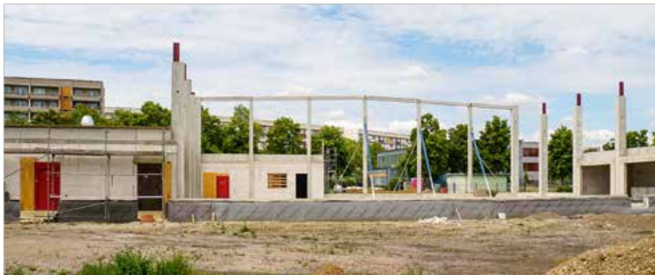
Sobald die Dachbinder montiert sind, kann mit dem Ausbau des eigentlichen Hallenkörpers begonnen werden.
