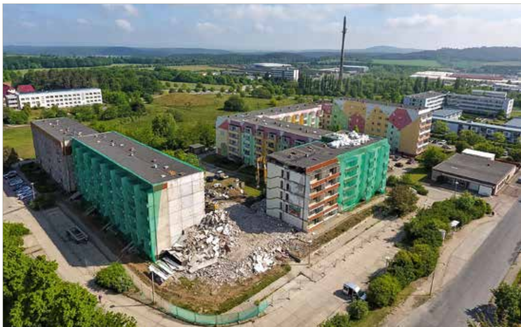
Zwei Blöcke mit insgesamt 99 Wohnungen werden zurück gebaut. Foto: Frank Graubaum
