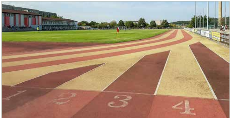
Die in die Jahre gekommene Leichtathletikanlage im Sportforum, kann dank der Bundesförderung, umfangreich saniert werden.
