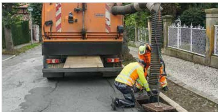
Vor der Reinigung der Gullys müssen die Bauhofmitarbeiter die bis zu 40 kg schweren Gitterroste entfernen.
