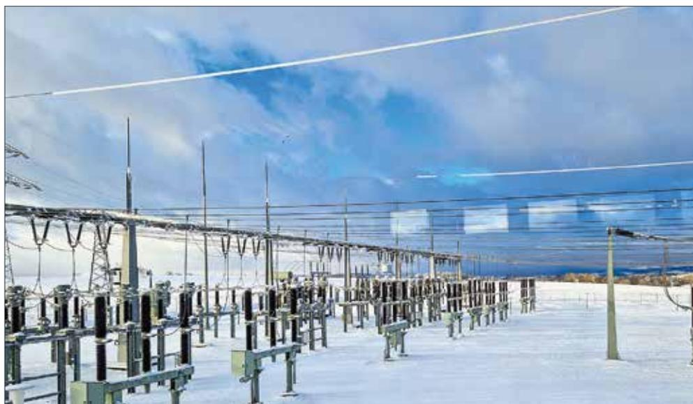
Schwerer Eisbehang auf Leiterseilen gepaart mit Sturmböen kann zu Kurzschlüssen und somit Stromausfällen führen. Foto: Avacon Netz GmbH
